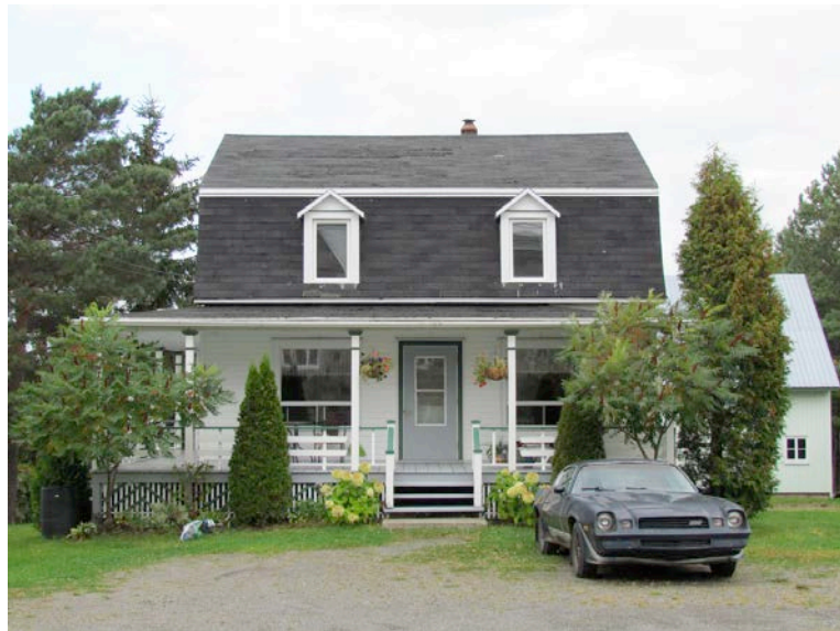
Maison ayant un fort potentiel de mise en valeur; en changeant le parement et les fenêtres, sa valeur patrimoniale serait considérablement accrue. 341, rue Principale, Saint-Modeste. IMG_1074.jpg
