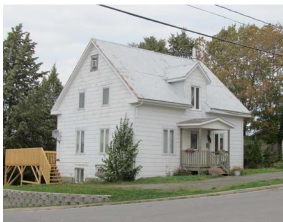
Maison dont il ne reste que la forme d'origine. 333, rue Principale, Saint-Modeste. IMG_1108.jpg
