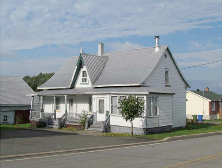
Quelques rénovations mineures permettraient d'améliorer l'état physique de cette maison sise au 3, route de l'Église Nord, Saint-Modeste. IMG_1009.jpg
