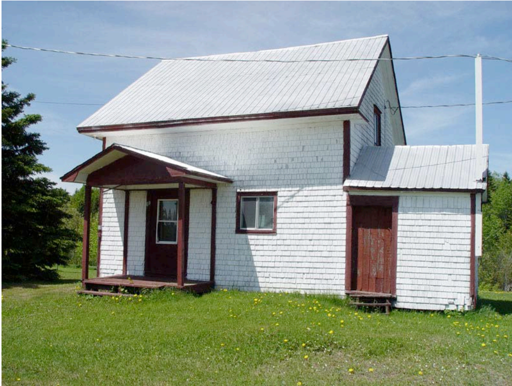
Autre exemple de bâtiment associé à l'architecture de colonisation : la maison du fermier. 10, rue Massé. Photo : MRC de Rivière-du-Loup. DSC06511.JPG
