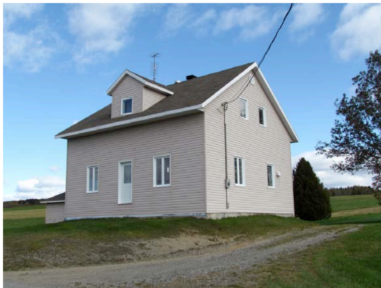
Le 346, 3 e Rang du Sud-du-Lac. Ce bâtiment érigé vers la fin du 19 e siècle pourrait faire l'objet de travaux de restauration de manière à le rapprocher de son état d'origine. IMG_1741.jpg
