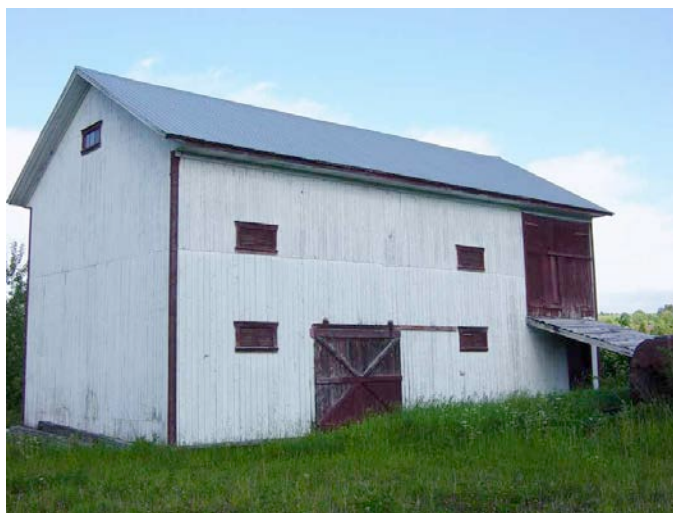
Bâtiment secondaire construit au début des années 1910 qui servait à l'origine d'étable au meunier Eugène Ouellet. Les clients de la meunerie y logeaient aussi leurs chevaux en attendant la mouture des grains. Le bâtiment abrite aujourd'hui une collection d'instruments aratoires du 19 e siècle. 18, rue Massé. Photo : Société de Conservation du Patrimoine Massé de Saint-Hubert. Grange_meuniermoulinfarine co.jpg
