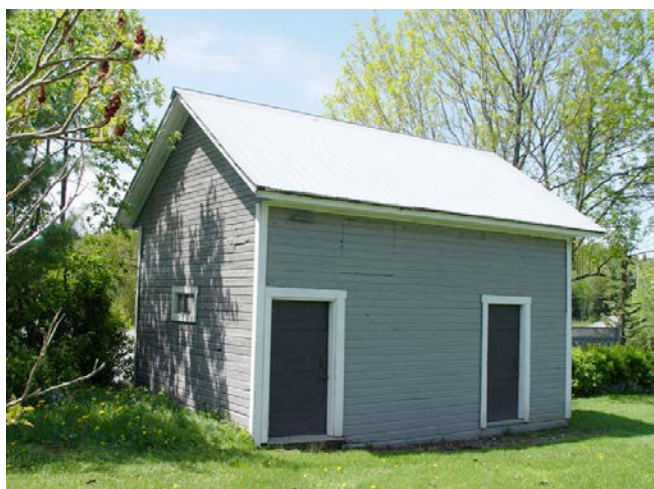
Remise de la maison Maurice-Massé, datant du début des années 1950. 1, rue Massé. Photo : MRC de Rivière-du-Loup. DSC06528.JPG
