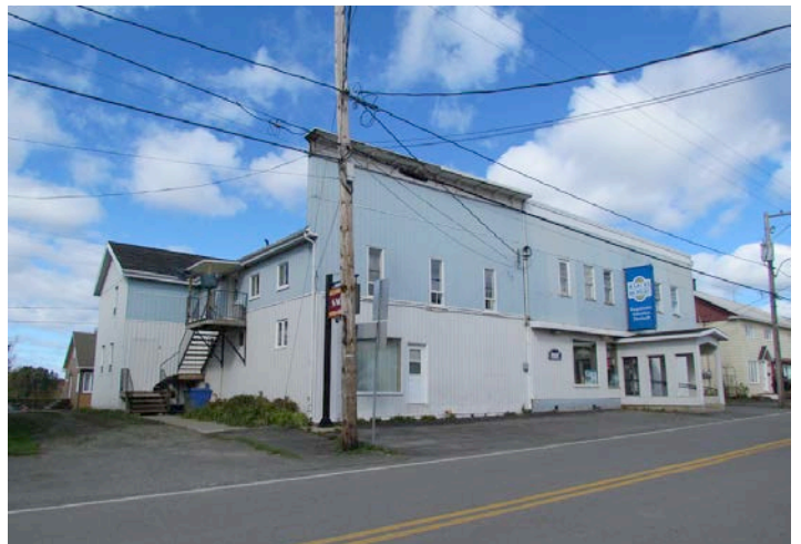
Le 6-10, chemin Taché Est. IMG_1618.jpg
