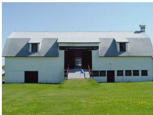
Grange principale de la ferme, datant de 1932. Elle est venue remplacer la première grange de la ferme incendiée cette année-là en même temps que le moulin. Le bâtiment sert maintenant d'usine de fabrication de clôtures à neige. 7, rue Massé. Photo : MRC de Rivière-du-Loup. DSC06474.jpg
