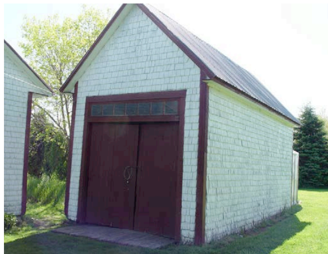
Glacière, construite vers 1920. On y entreposait des blocs de glace destinés à la conservation des aliments et à approvisionner d'autres petites glacières domestiques. 5, rue Massé. Photo : MRC de Rivière-du-Loup. DSC06459.JPG
