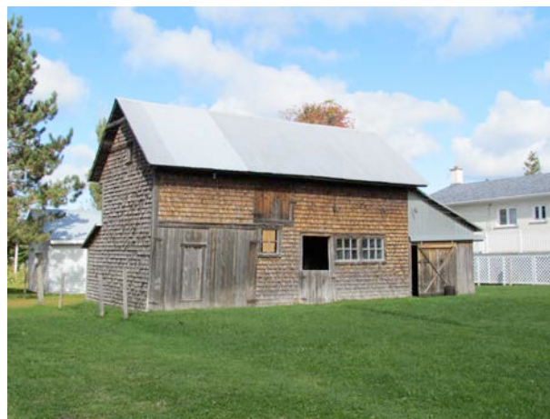
Petite grange-étable présentant une parfaite authenticité architecturale, typique des noyaux villageois. Notez l'arrangement de la porte et des fenêtres qui révèlent la fonction d'origine d'étable. 23, chemin Taché Ouest. IMG_1582.jpg
