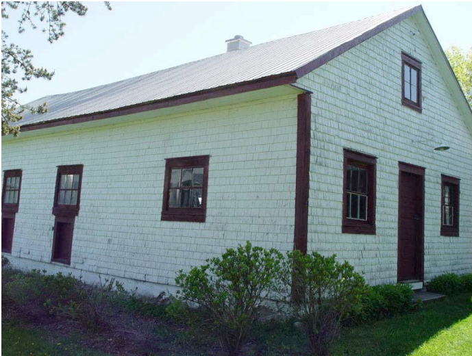
Porcherie, un édifice présentant une parfaite authenticité architecturale. 5, rue Massé. Photo : MRC de Rivière-du-Loup. DSC06461.JPG
