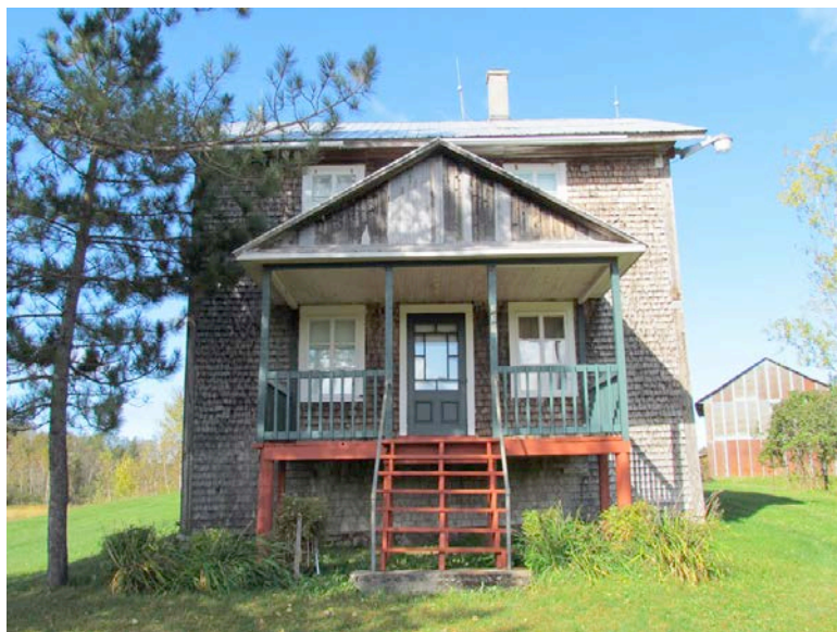
Le 239, chemin Taché Ouest. L'édifice aurait avantage à conserver son revêtement mural de bardeau de bois. IMG_1530.jpg
