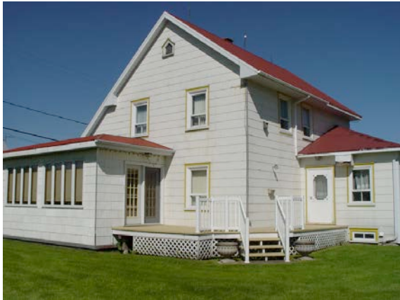
La maison Camille-Massé, érigée vers 1890 et agrandie au début de la décennie 1900. Elle est encore habitée par un membre de la famille Massé. 49, rue Principale. Photo : MRC de Rivière-du-Loup. DSCo6451.jpg
