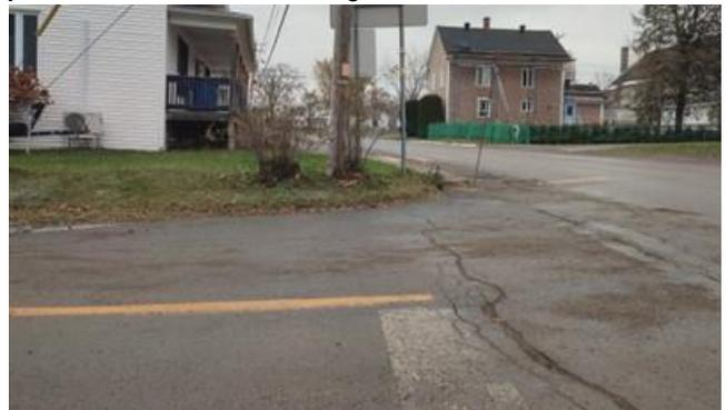
Photo 4 – Approche nord. Triangle de visibilité réduit par la présence de signalisation-poteau-végétation.
