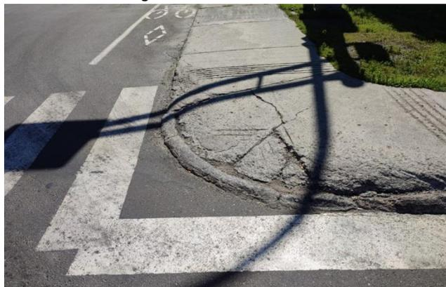
Photo 2 – Quadrant sud-ouest de l'intersection des Marguerites – Bateau-pavé dégradé limitant l'accessibilité universelle.
