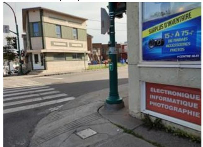
Photo 3 - Approche nord - Visibilité d'anticipation limitée en raison du bâtiment à proximité de la chaussée. Bateau-pavé dégradé limitant l'accessibilité universelle.
