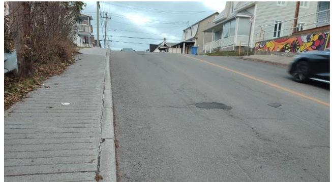
Photo 2 – Approche ouest - Distance de visibilité d'arrêt insuffisante en raison de la pente.
