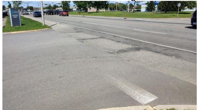
Photo 8 – Accès au Super C – Ligne d'arrêt effacée.
