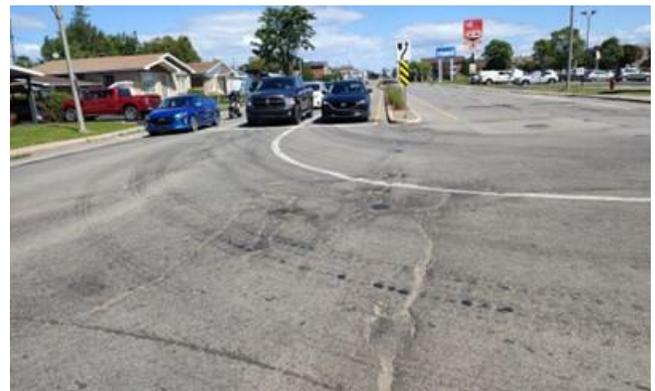
Photo 3 - Marques sur la chaussée montrant des changements de voies lors du virage double.
