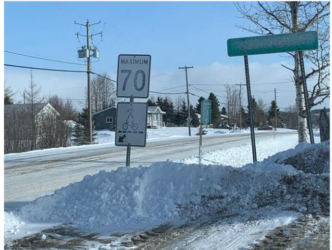
Photo 1 – Signalisation non conforme en direction est, à l'approche du 3<sup>e</sup> rang. Panneau de passage pour piétons-cyclistes inapproprié et plus d'un panneau de catégories différentes (prescription et danger) sur le même support.
