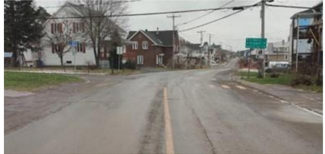
Photo 1 – Approche est (rue Deschênes). Panneau d'indication portant à confusion. Marquage du passage pour piéton effacé et non conforme.
