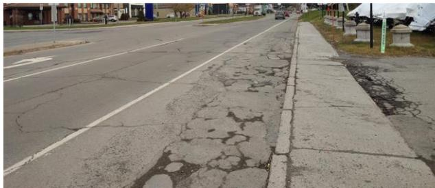
Photo 4 – Boulevard Cartier en direction sud. Bande cyclable dégradée et large pouvant être confondue avec du stationnement sur rue. Discontinuité du trottoir.
