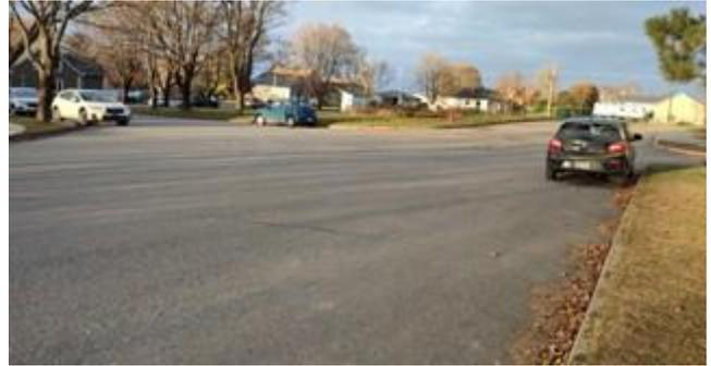
Photo 1 – Rue du Couvent (intersection au coin de l'école). Absence de marquage. Surlargeur de la chaussée et des rayons de courbure. Absence de mode de gestion. Véhicules stationnés dans l'intersection.
