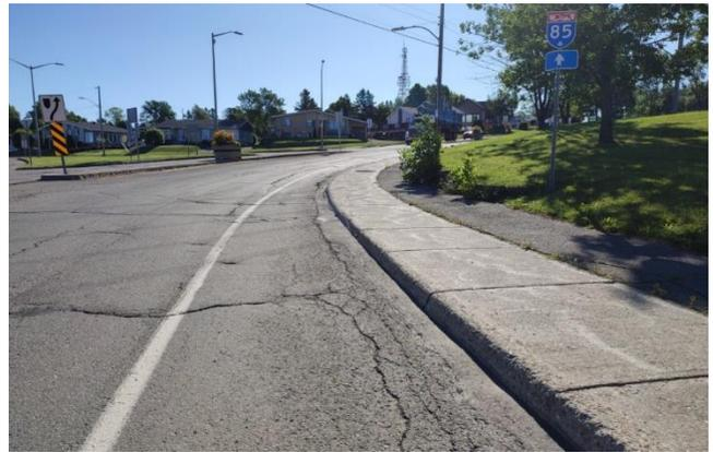
Photo 1 - Approche nord. Visibilité du passage pour personne limitée. Absence de panneau « Passages pour personnes » de part et d'autre du passage.
