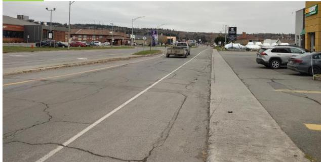
Photo 1 – Boulevard Cartier en face du Subway. Stationnement à angle, trottoir abaissé et bande cyclable dégradée.
