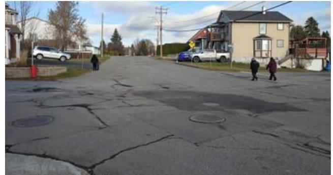
Photo 3 – Chaussée dégradée, absence de marquage et circulation piétonne. Pente à l'approche est limite la visibilité.
