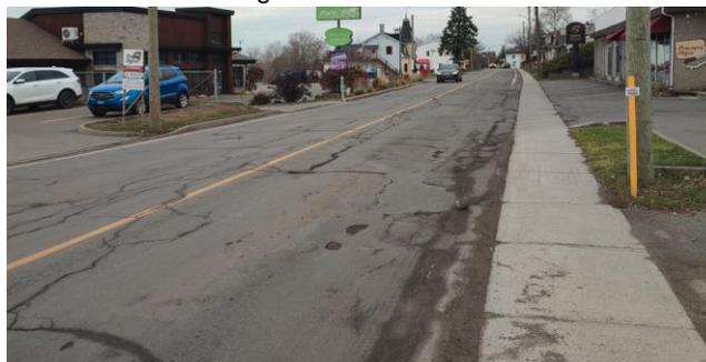
Photo 5 – Rue Fraser. Chaussée dégradée et trottoir abaissé sur une longue distance.
