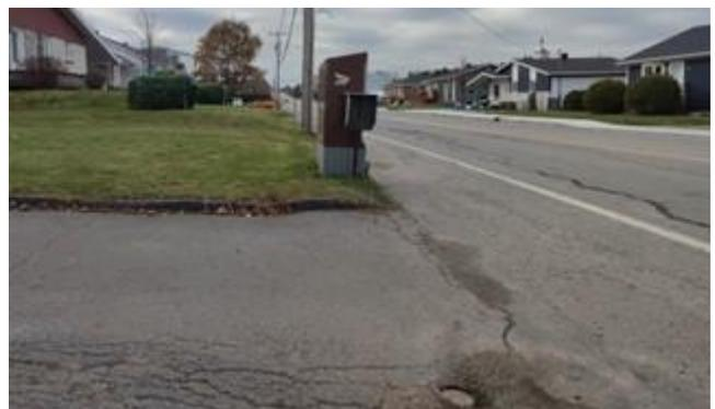
Photo 3 – Visibilité d'insertion obstruée par le poteau d'Hydro-Québec et la boîte postale.
