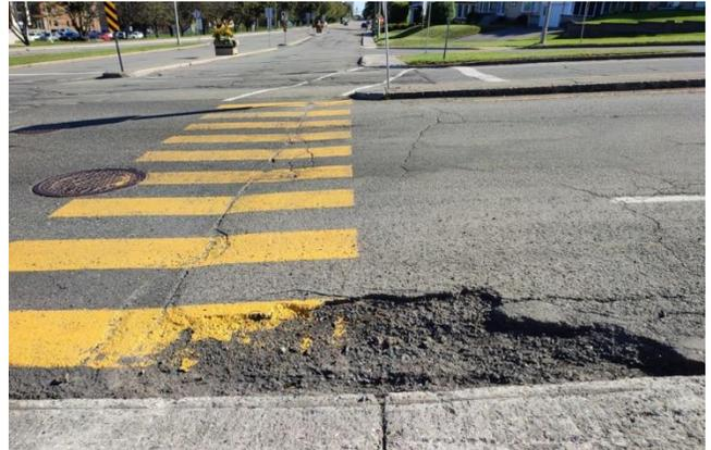
Photo 2 - Passage pour personne dégradé. Les abaissés de trottoir ne sont pas alignés et le terre-plein n'offre pas de protection.
