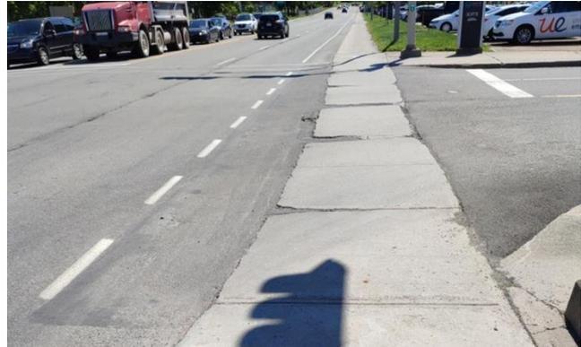
Photo 4 – Approche ouest de l'intersection du centre commercial – Trottoir abaissé en présence de feux de circulation.
