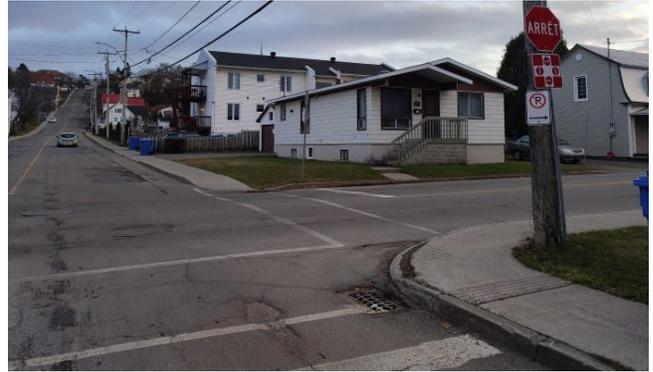
Photo 1 – Plus d'un panneau sur un même support à l'approche nord - Bateau-pavé dégradé au quadrant nord-ouest. Absence de trottoir sur la portion sud-ouest de la rue Frontenac.
