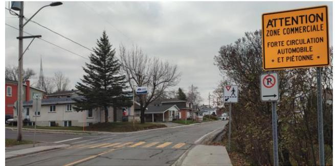
Photo 1 – Intersection rue Fraser / rue Lévis. Signalisation de danger non conforme. Signalisation du passage pour piéton non conforme.
