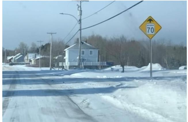
Photo 2 – Signal avancé de limite de vitesse non conforme en direction ouest (transition 50 km/h à 70 km/h).
