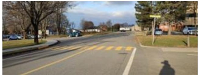
Photo 2 – Rue du couvent (intersection coin de l'école). Absence de bateau pavé et discontinuité des trottoirs – Aucune signalisation pour informer les conducteurs de la présence d'une zone scolaire.
