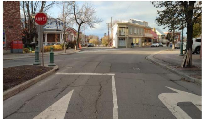
Photo 2 – Absence de ligne d'arrêt pour le mouvement de virage à droite.
