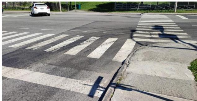
Photo 1 – Approche ouest (rue des Marguerites) – Empiètement des véhicules sur le trottoir lors de la manœuvre de virage à droite.
