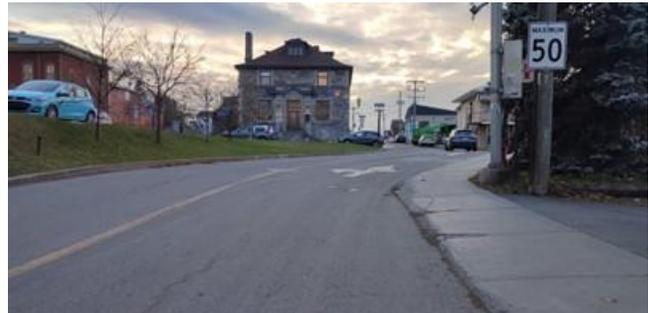
Photo 2 – Approche est - Distance de visibilité du mode de gestion limitée en raison de la courbe.
